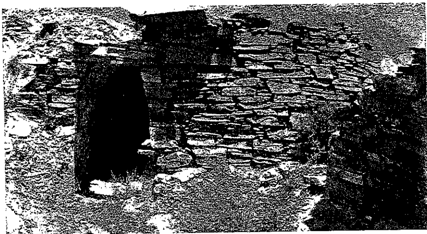
Puerta de una construcción elíptica en Titiconte, en cuyo muro se observa el uso de lajas y piedras canteadas.
